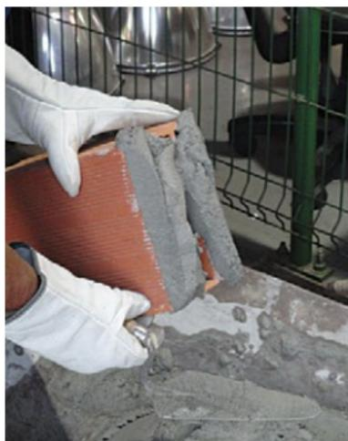
e) Lateralmente, deve-se assegurar um recobrimento dos fios extremos do Murfor® com argamassa de, no mínimo, 15 mm. Para alvenarias expostas à umidade, reforçadas com Murfor®, recomenda-se aplicação de argamassa de revestimento na(s) face(s) exposta(s).
