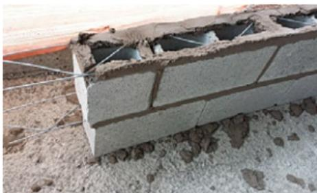
**Atenção:** é preciso que os fios longitudinais e os nós da treliça Murfor® estejam envolvidos pela argamassa; do contrário, a eficiência do reforço fica comprometida. Por isso, uma atenção especial deve ser tomada na escolha da largura do Murfor® em função das dimensões do bloco vazado.
