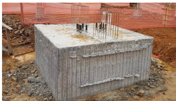
Figura 7 - À esquerda, bloco com APS e Fôrma Incorporada antes da concretagem; à direita, mesmo bloco já concretado
