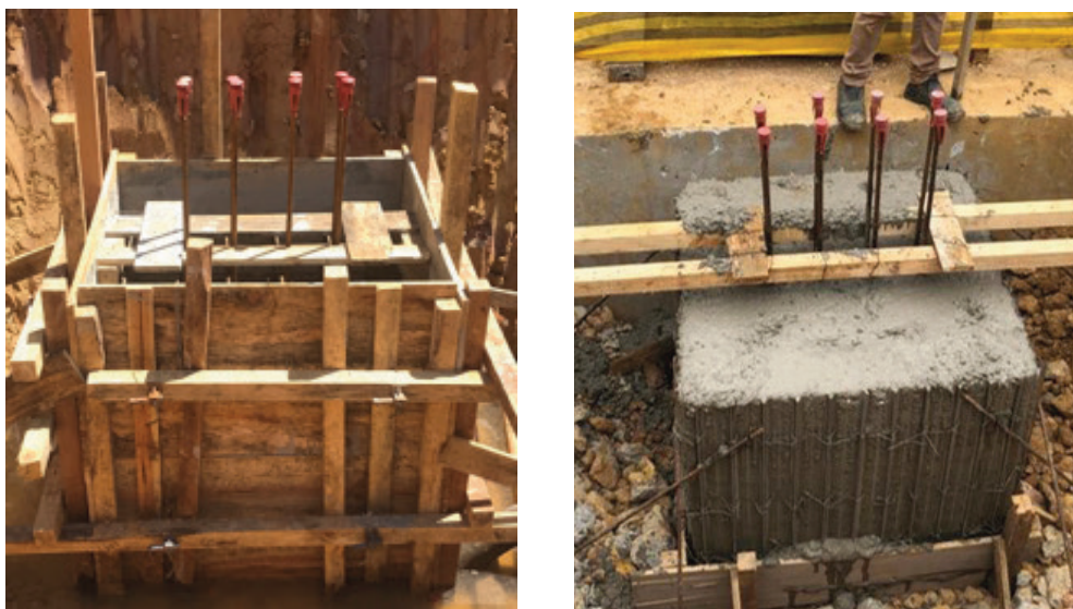
Figura 4 – À esquerda, elemento estrutural com fôrma de madeira, que exigirá desforma; à direita, peça com fôrma incorporada
