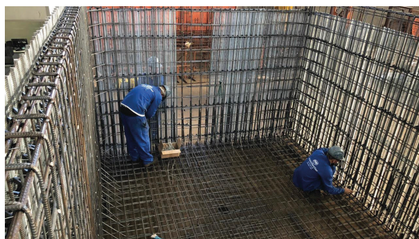
Figura 6 - APS e Fôrma Incorporada: à esquerda, em canaleta; à direita, em reservatório
