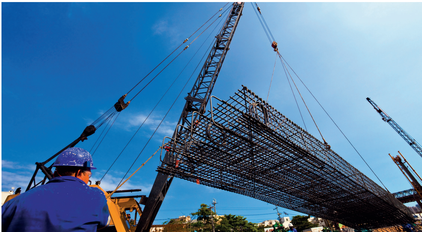
Figura 2 - APS sendo posicionada para posterior concretagem
