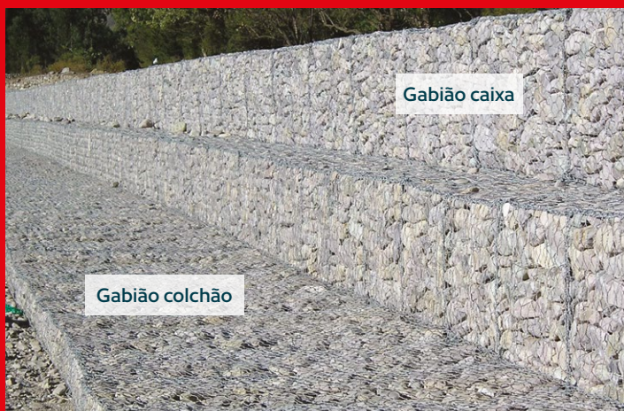
Obras de retificação de cursos d'água
