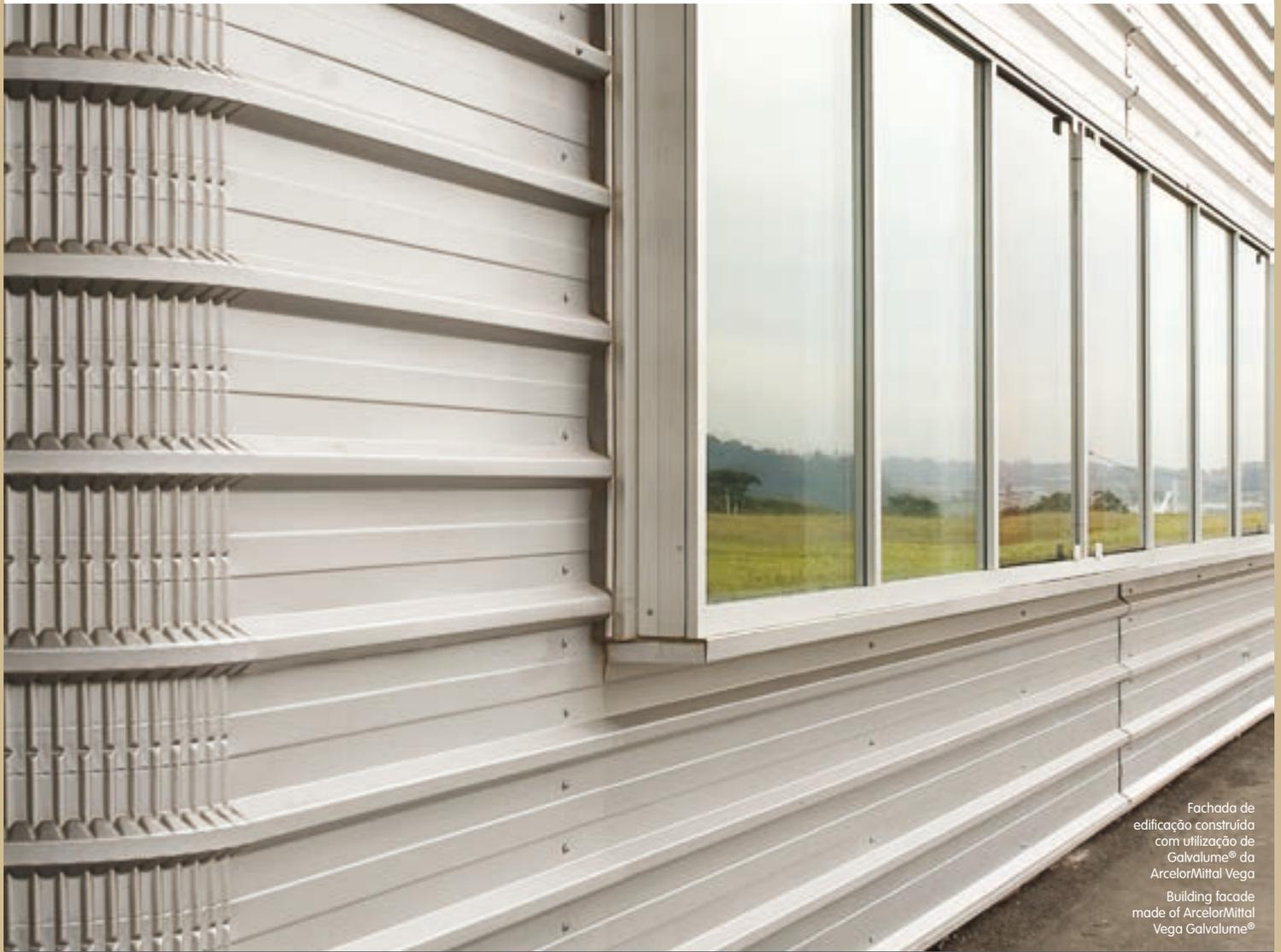
Fachada de edificação construída com utilização de Galvalume® da ArcelorMittal Vega
