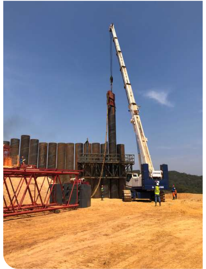
Martelo vibratório suspenso em guindaste
