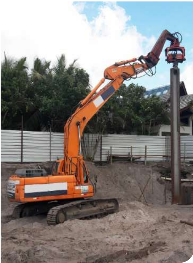
Martelo vibratório acoplado em escavadeira
