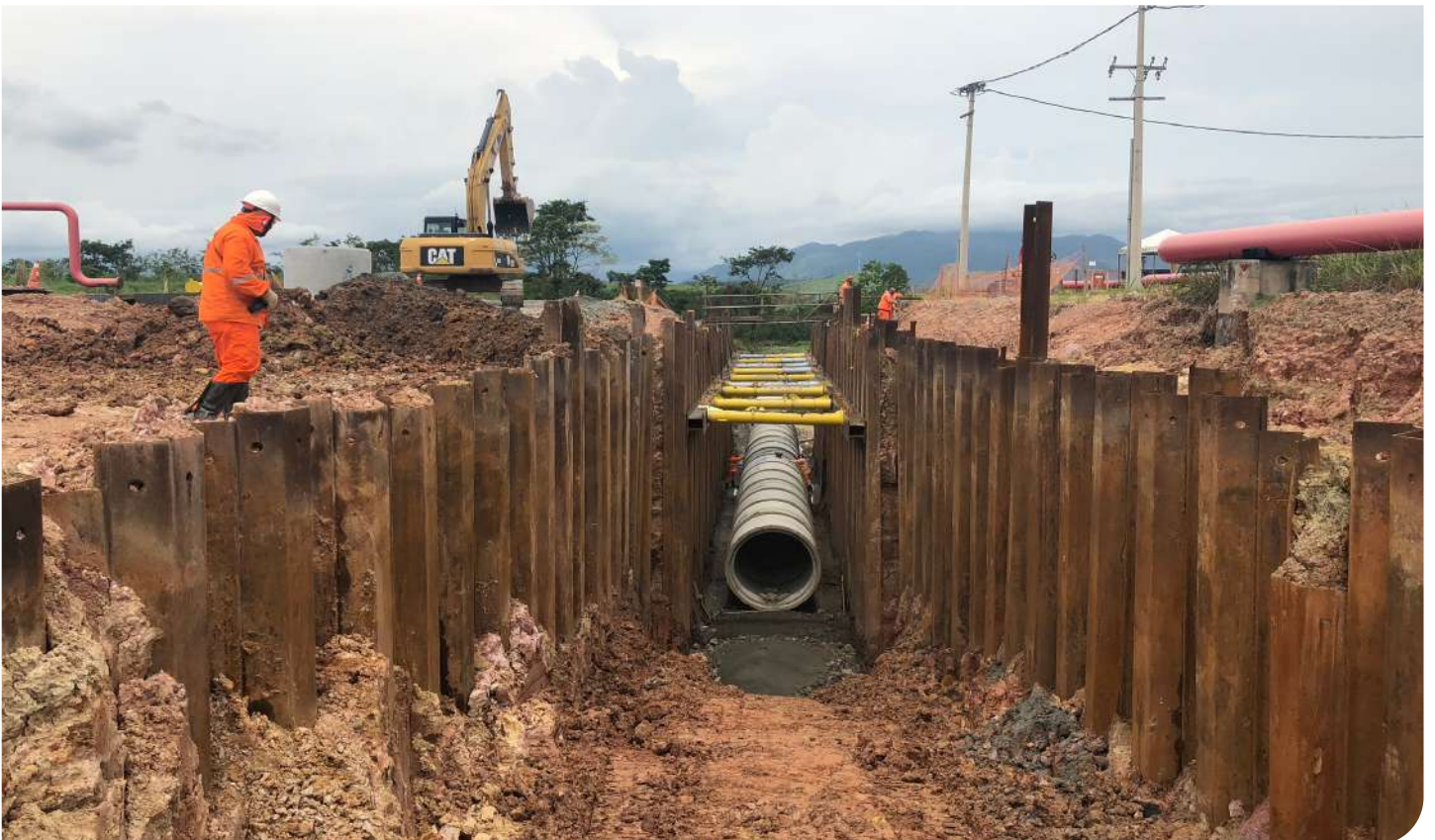
Escoramento de Vala Local: Itaboraí, RJ
