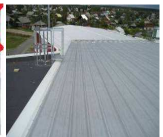
Telhado sem a presença de resíduos
