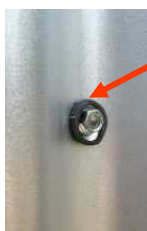
Ponto de depressão causado por parafuso muito apertado
