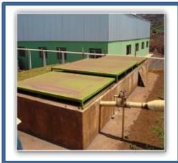
Sistema de tratamento de afluentes: Caixa separadora água-óleo; sistema fossa séptica e filtro anaeróbio
