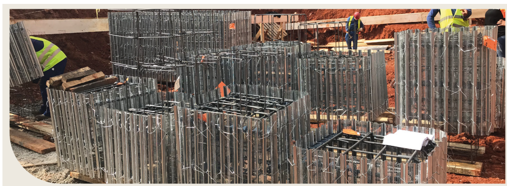
Figura 8 - Exemplo de blocos estocados no canteiro
