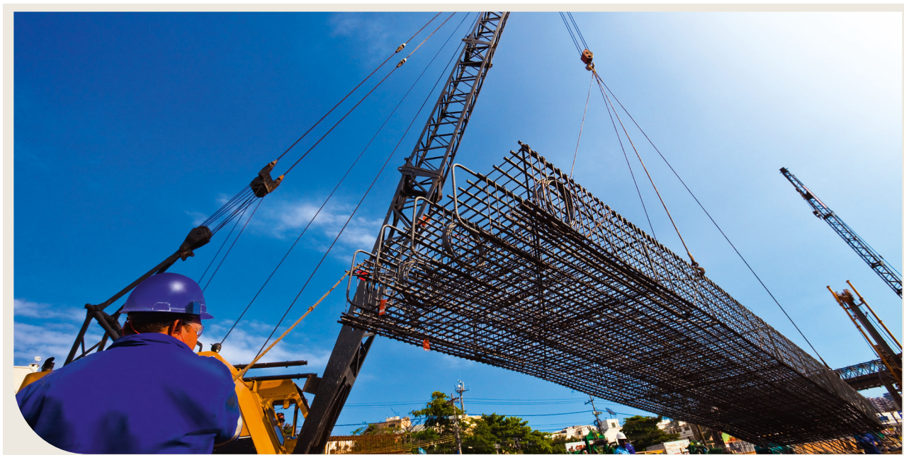
Figura 2 - APS sendo posicionada para posterior concretagem
