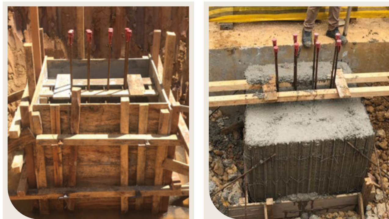
Figura 4 – À esquerda, elemento estrutural com fôrma de madeira, que exigirá desfôrma; à direita, peça com Fôrma Incorporada
