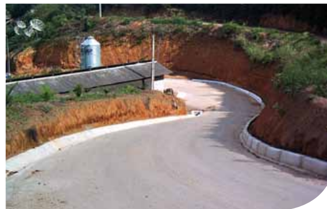
Estrada capixaba pavimentada com o Revsol®, produzido a partir do processo de fabricação de placas e bobinas em Tubarão
