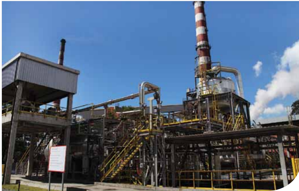
Instalações do Sistema Claus de Dessulfuração em Tubarão
