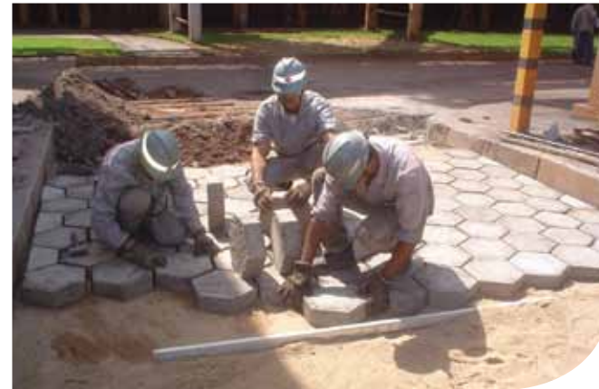
Bloquetes ecológicos produzidos a partir de escória são usados na pavimentação urbana
