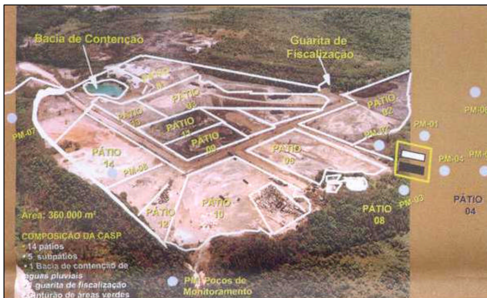
Figura 6-1: Vista Geral da Central de Armazenamento de Sub Produtos – CASP.
