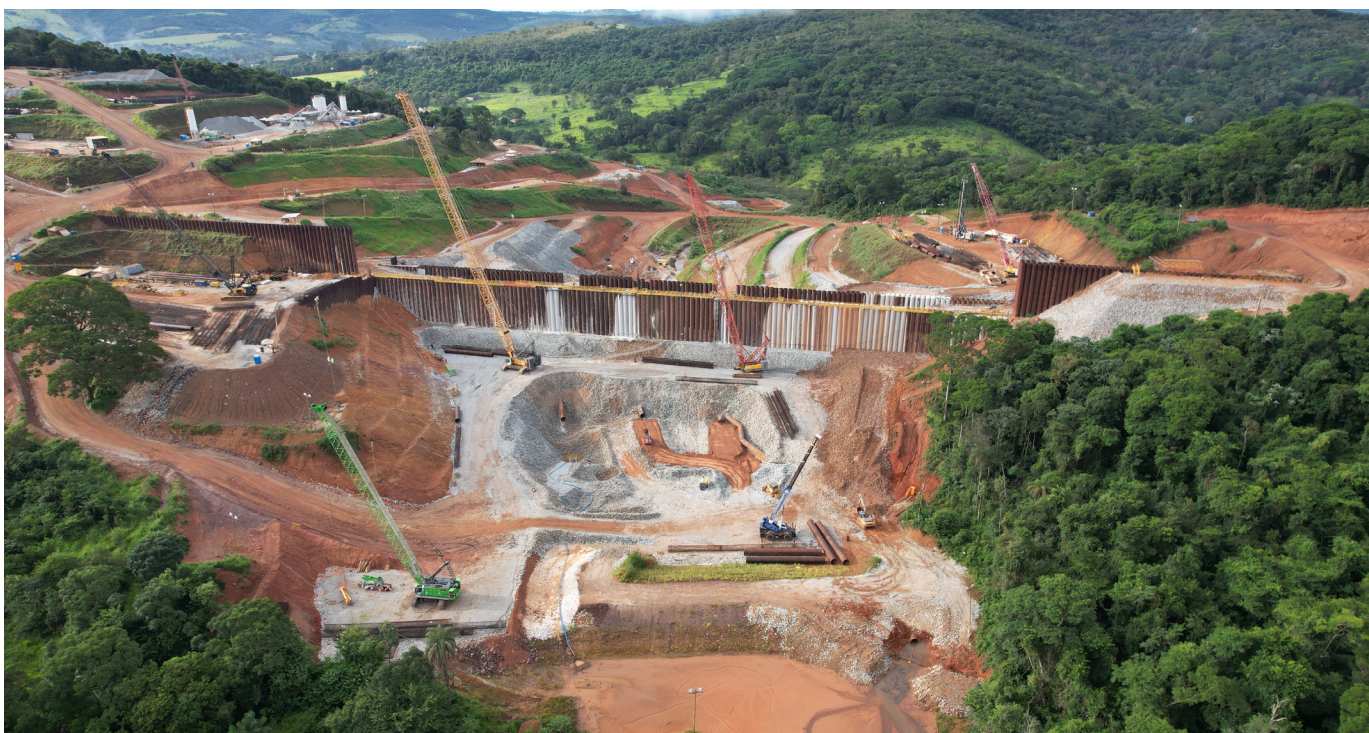
A barreira de 400 metros de largura e 50 metros de altura já fecha completamente o vale
