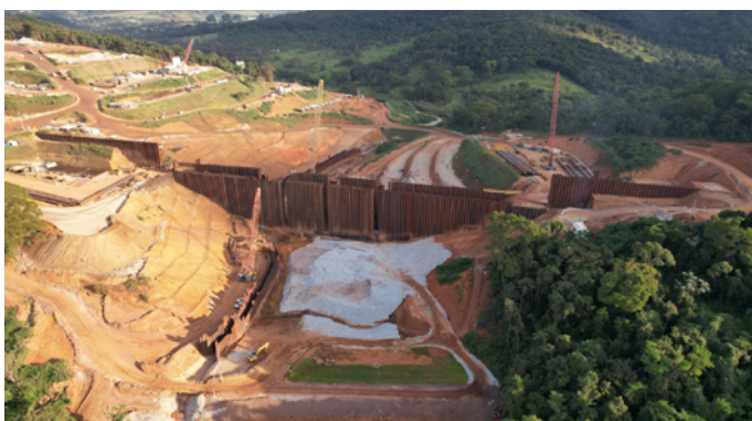
Obras da ECJ estão avançando
