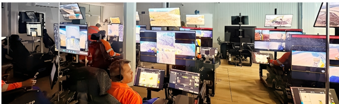
Os equipamentos presentes na barragem estão sendo controlados do Centro de Operações Remotas (COR)
