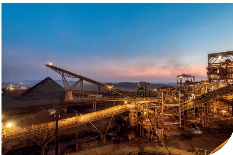
O rejeito passa por uma decantação natural, **sem riscos para o meio ambiente**, e a água recuperada é reutilizada no processo. Os rejeitos são posteriormente dispostos em pilhas num formato especial, para a drenagem final.
