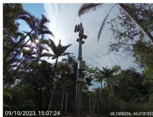
Visita de campo – Instalação da Sirene 06 . Barragem Serra Azul, ArcelorMittal. Itatiaiuçu (MG), 09/10/2023
