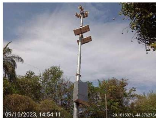
Visita de campo – Instalação da Sirene 05 . Barragem Serra Azul, ArcelorMittal. Itatiaiuçu (MG), 09/10/2023
