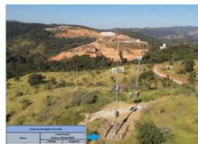
Visita de campo - Instalação da Sirene 02 . Barragem Serra Azul, ArcelorMittal. Itatiaiuçu (MG), 09/10/2023
