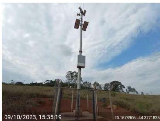
Visita de campo - Instalação da Sirene 04 . Barragem Serra Azul, ArcelorMittal. Itatiaiuçu (MG), 09/10/2023
