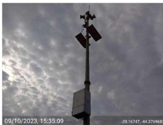
Visita de campo - Instalação da Sirene 04 . Barragem Serra Azul, ArcelorMittal. Itatiaiuçu (MG), 09/10/2023
