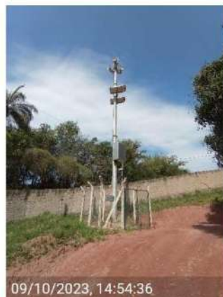
Visita de campo – Instalação da Sirene 05 . Barragem Serra Azul, ArcelorMittal. Itatiaiuçu (MG), 09/10/2023
