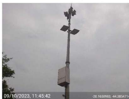
Visita de campo - Instalação da Sirene 03 . Barragem Serra Azul, ArcelorMittal. Itatiaiuçu (MG), 09/10/2023
