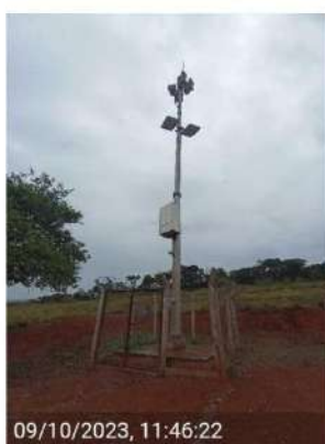
Visita de campo - Instalação da Sirene 03 . Barragem Serra Azul, ArcelorMittal. Itatiaiuçu (MG), 09/10/2023
