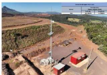
Visita de campo - Instalação da Sirene 01 . Barragem Serra Azul, ArcelorMittal. Itatiaiuçu (MG), 09/10/2023
