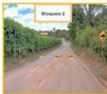
Lombada próxima a entrada da rua do cascalho.
