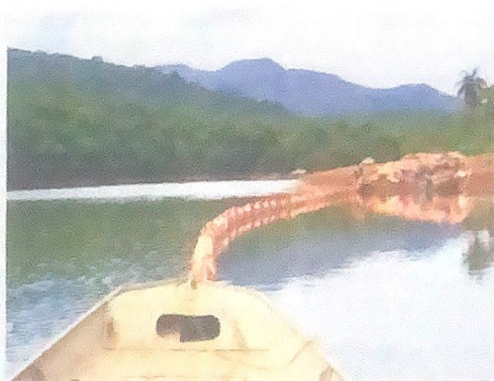
Figura 17 - Instalação das duas linhas das cortinas antiturbidez.
