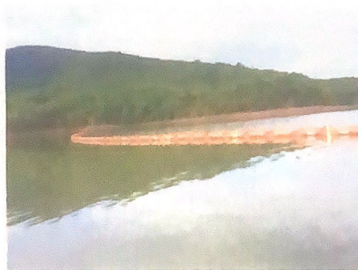
Figura 18 - Finalização da instalação das duas linhas de cortinas
