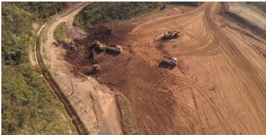
Figura 25: Detalhe da escavação de um dos dois Sump's.
