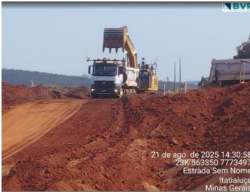
Figura 22: Detalhe do encaixe do acesso a barragem. Fonte da Imagem: BVP
