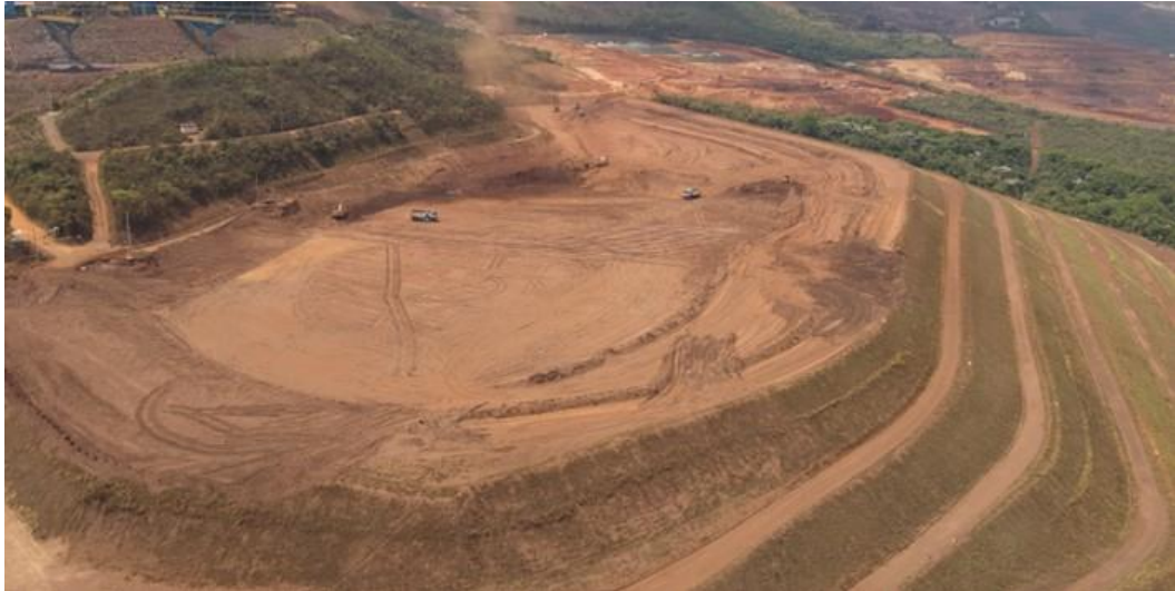
Figura 28: Escavação de rejeito.
