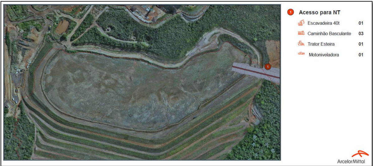
Figura 24: Detalhe da implantação do acesso e os equipamentos utilizados.
