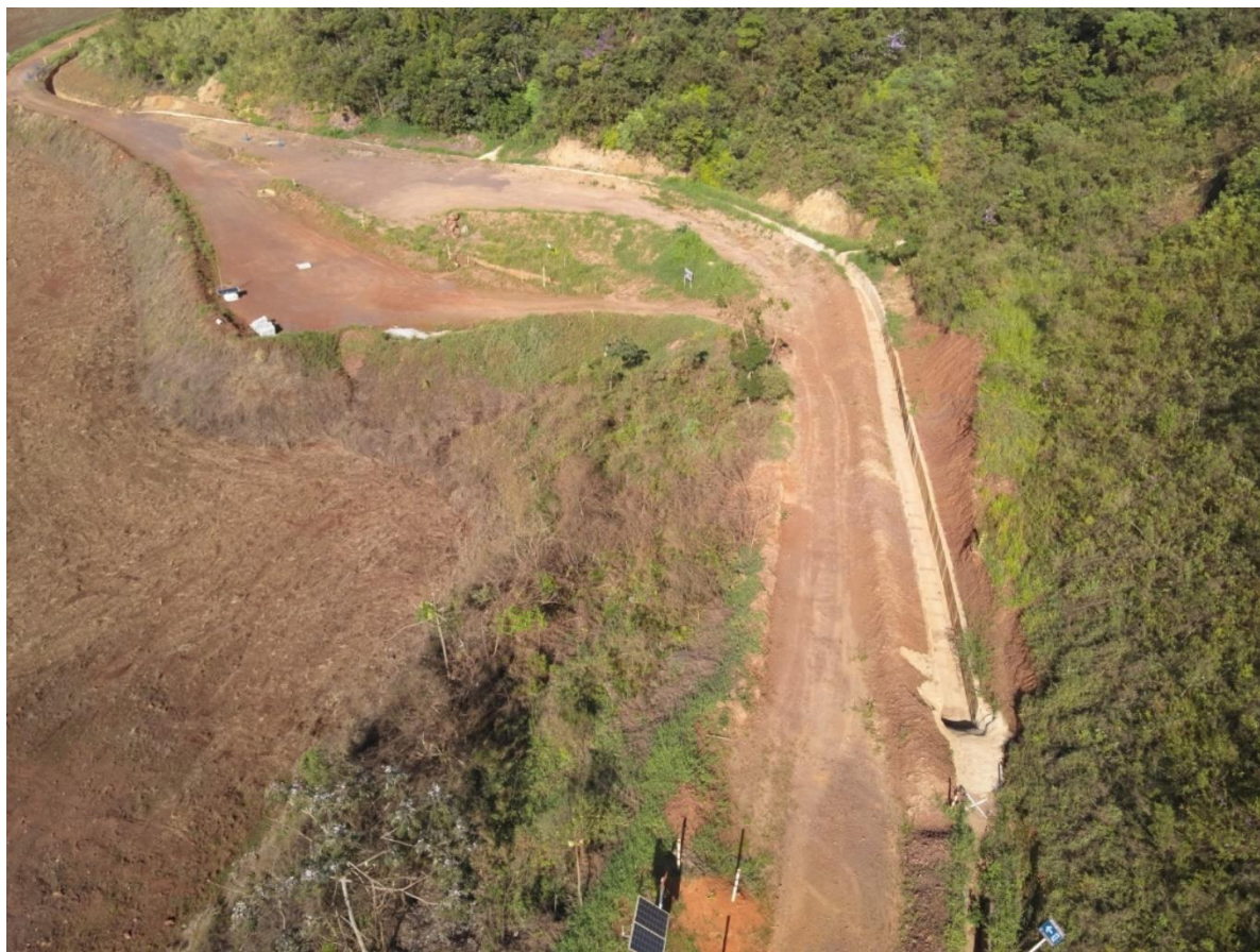
Figura 25: Canal de desvio.
