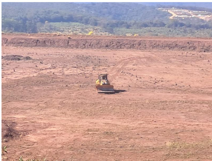
Figura 30: Equipamento não tripulado no interior da barragem.
