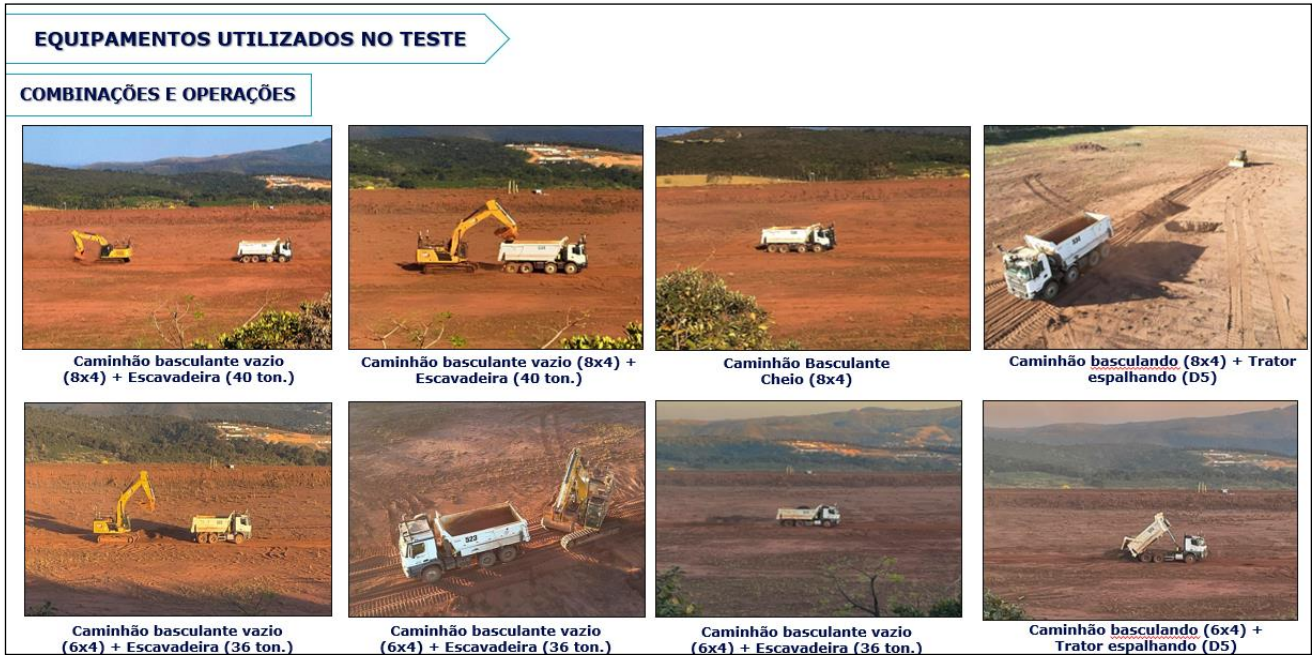
Figura 21: Detalhe da combinação dos testes com os equipamentos não tripulados no interior da barragem. Fonte da Imagem: BVP
