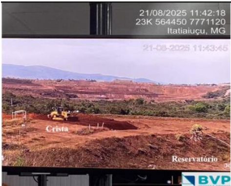
Figura 23: Detalhe do trator realizando o encaixe do acesso a barragem. Fonte da Imagem: BVP
