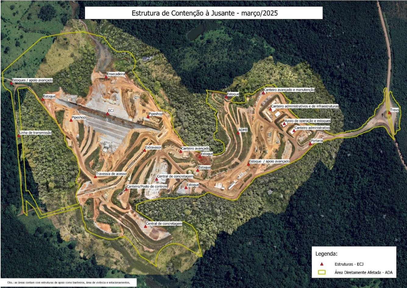
Figura 165: Layout das áreas da Estrutura de Contenção à Jusante (março/2025)
