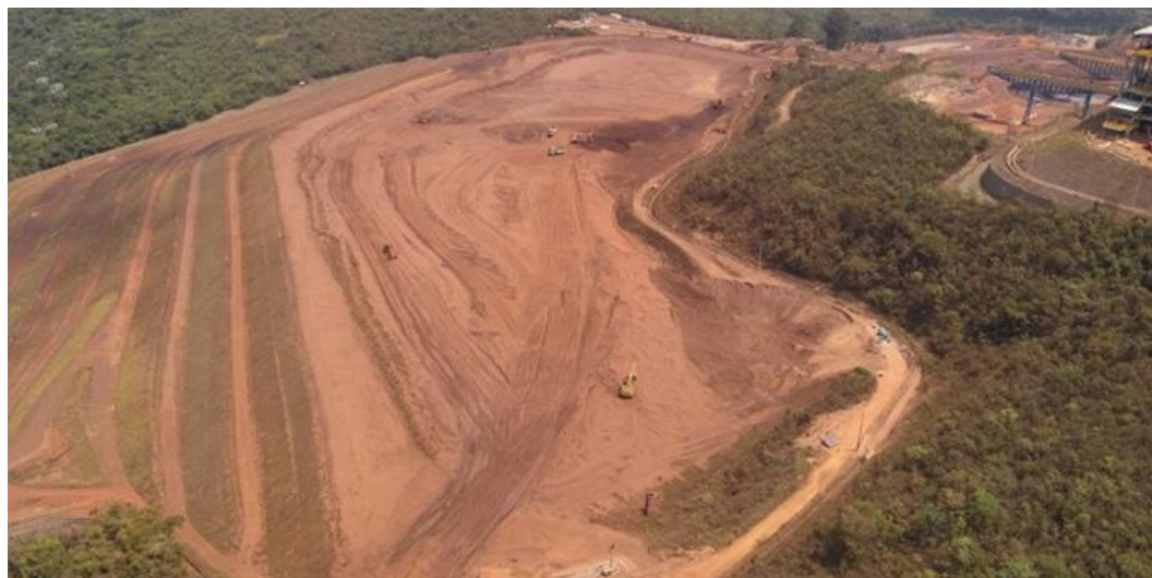
Figura 27: Barragem Serra Azul.
