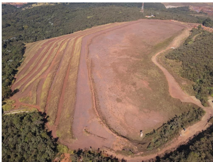
Figura 27: Ombreira Esquerda (Reservatório).
