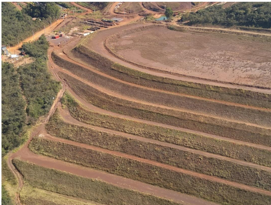
Figura 28: Ombreira Direita (Reservatório).
