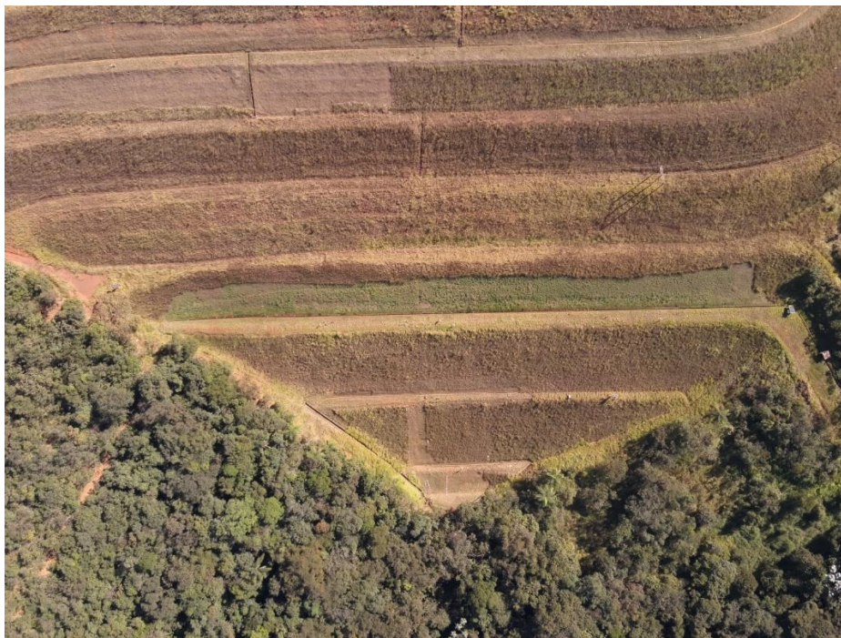
Figura 30: Taludes a jusante (Dique da Barragem).
