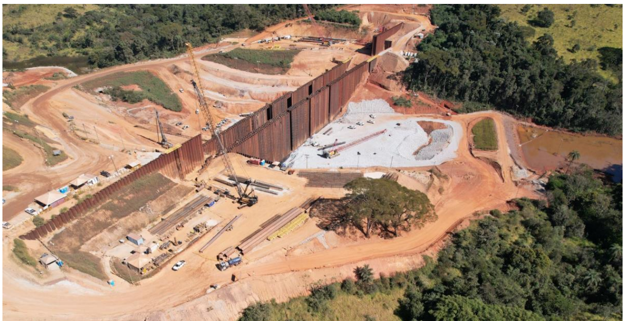
Figura 19: Vista da ECJ – junho/2024 (Aço e Gnaiss - Mista)
