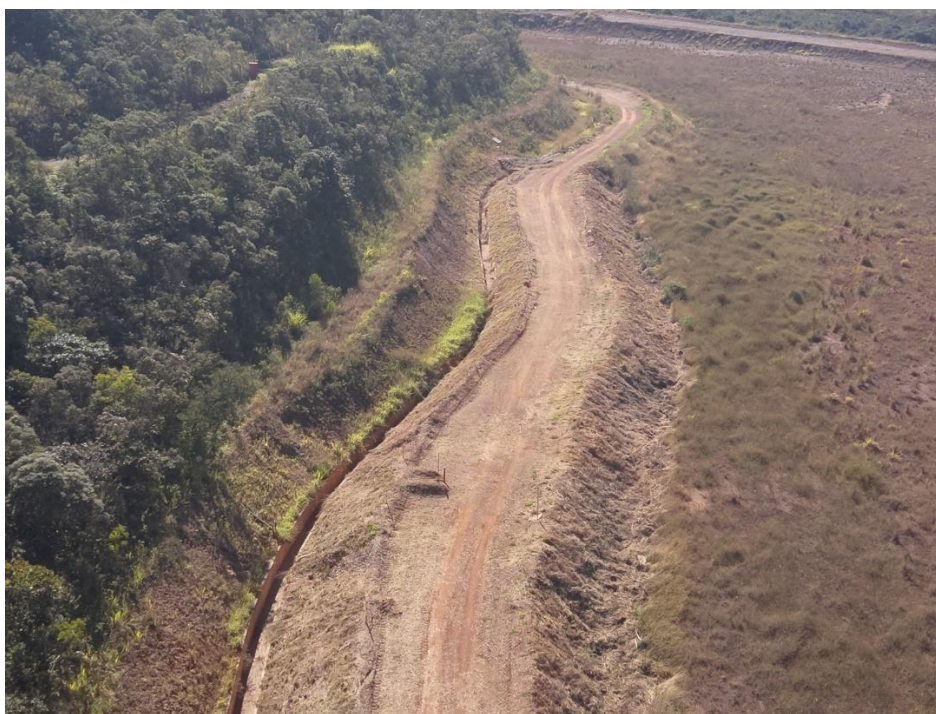
Figura 291: Montante a Barragem (canal de drenagem).
