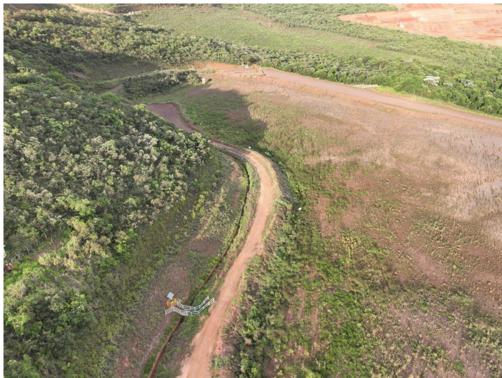
Figura 291: Montante a Barragem (canal de drenagem).
