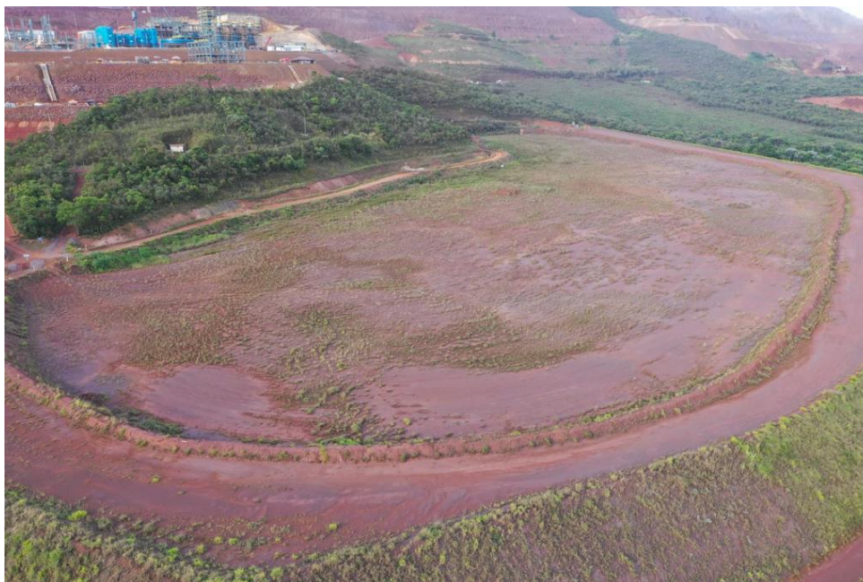
Figura 28: Ombreira Direita (Reservatório).
