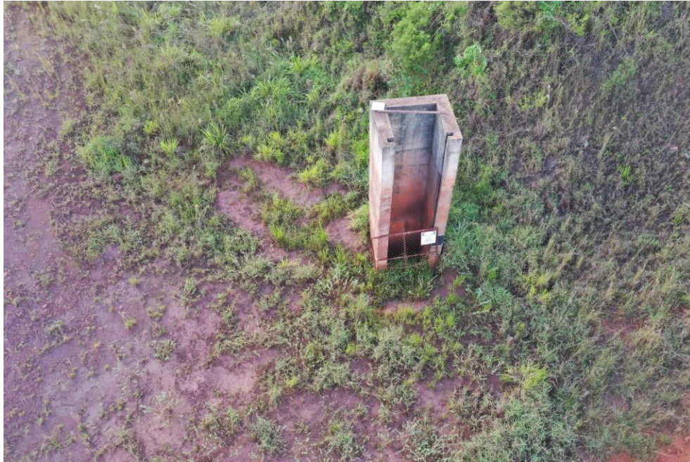
Figura 24: Reservatório contém a (tulipa de drenagem).
