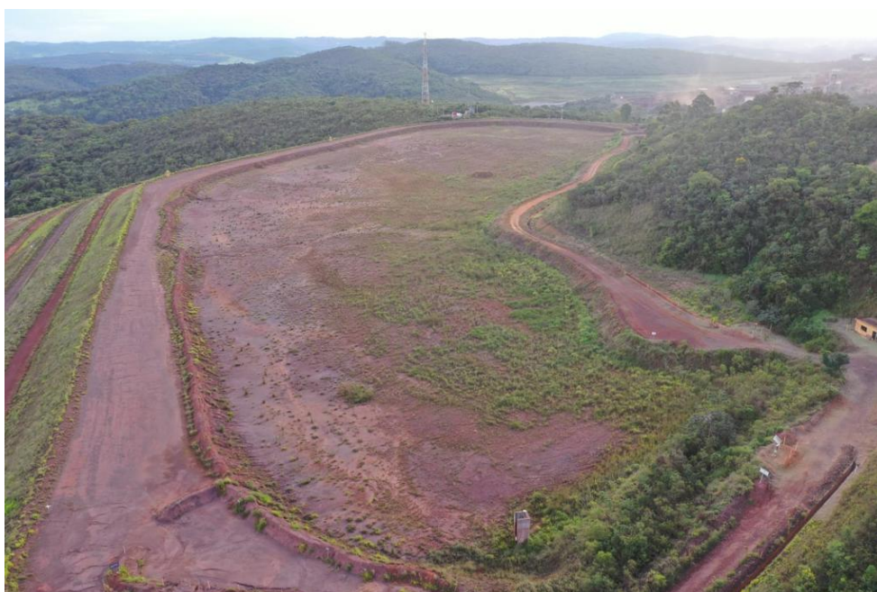
Figura 27: Ombreira Esquerda (Reservatório).
