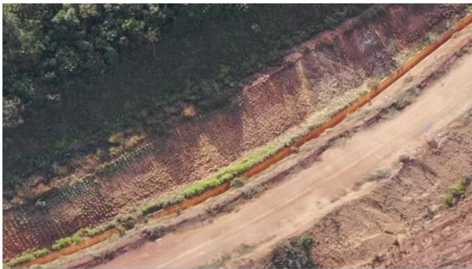
Figura 30: Canal de desvio.
