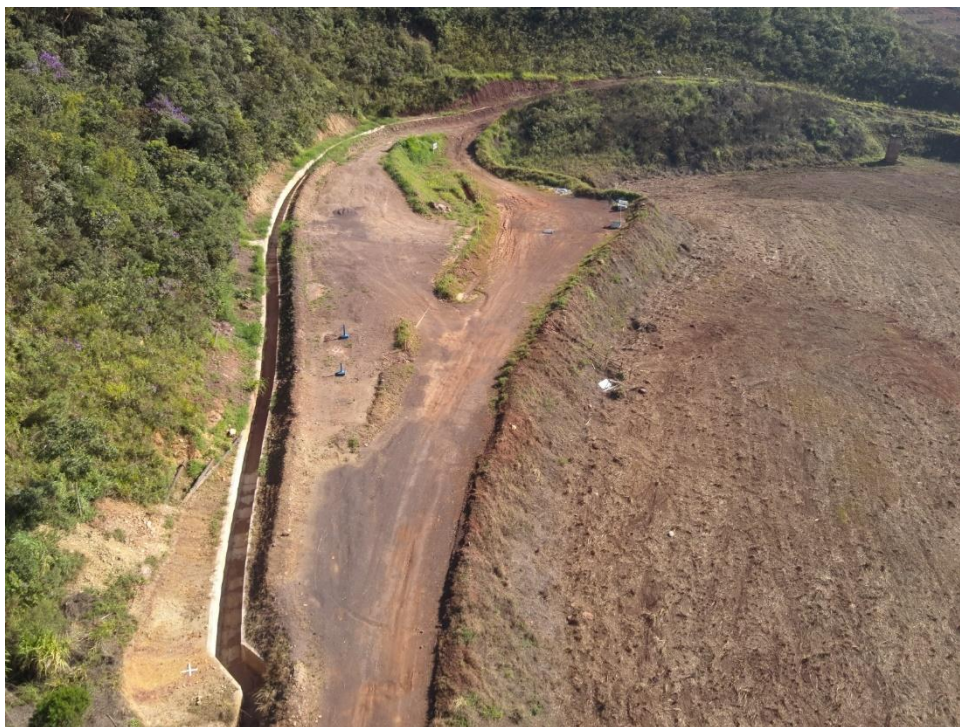
Figura 20: Ombreira Esquerda e canal de desvio (Reservatório).
