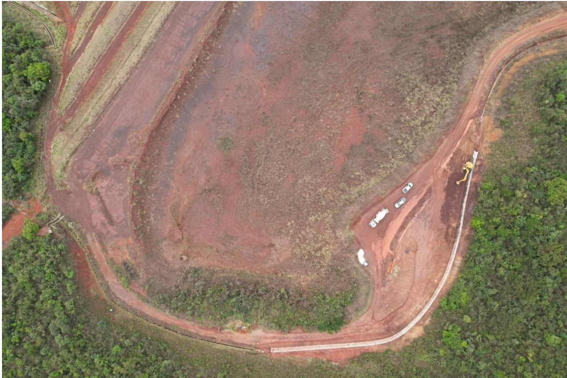
Figura 13: Complemento do canal de desvio.
