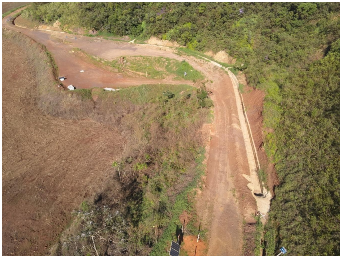
Figura 22: Canal de desvio.
