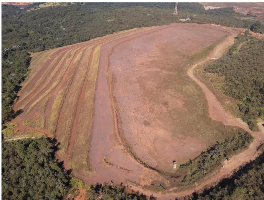
Figura 27: Ombreira Esquerda (Reservatório).
