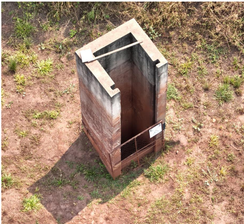
Figura 24: Reservatório contém a (tulipa de drenagem).
