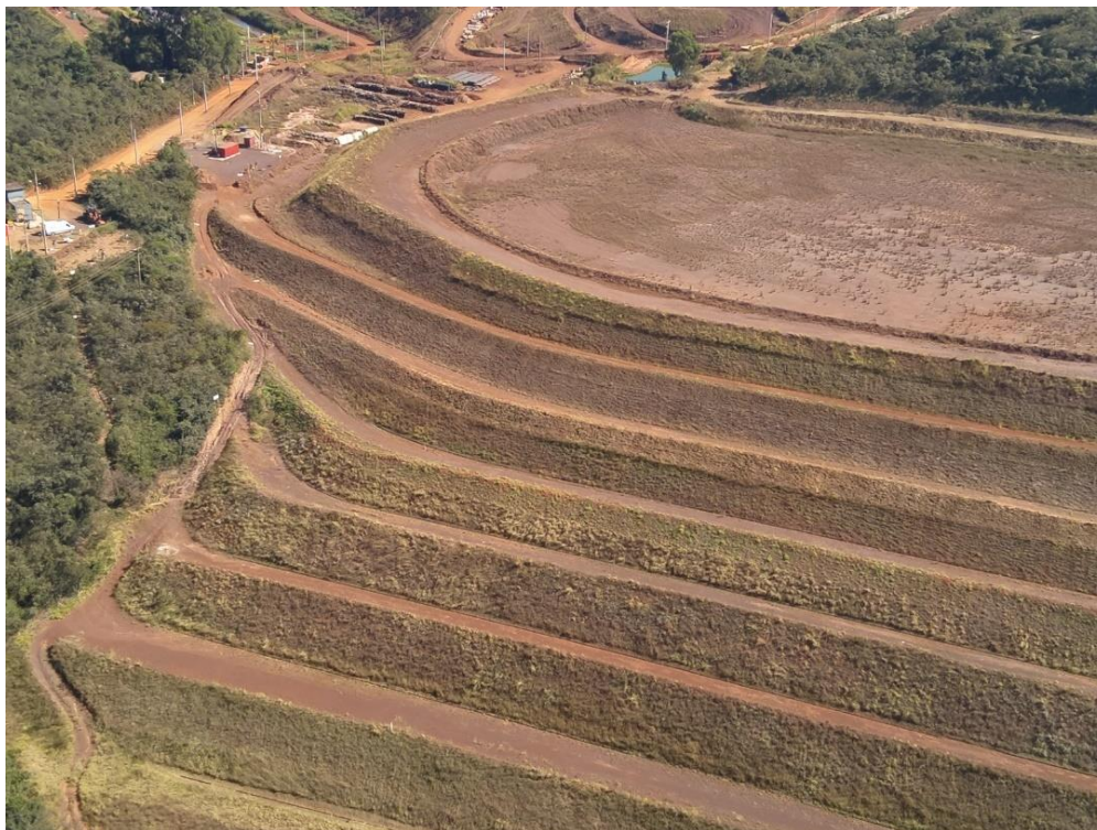
Figura 28: Ombreira Direita (Reservatório).
