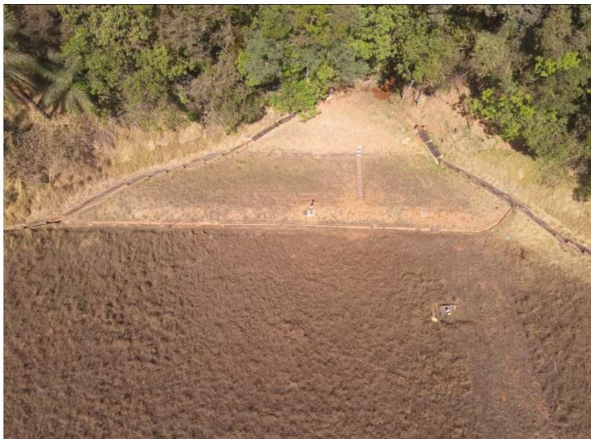
Figura 30: Taludes a jusante (Dique da Barragem).
