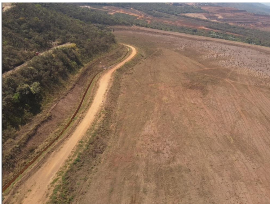
Figura 291: Montante a Barragem (canal de drenagem).
