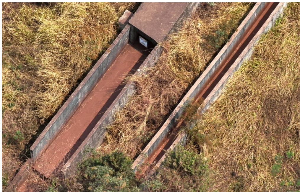
Figura 29: Drenagem (esquerda da tulipa / direita canal extravassor)
