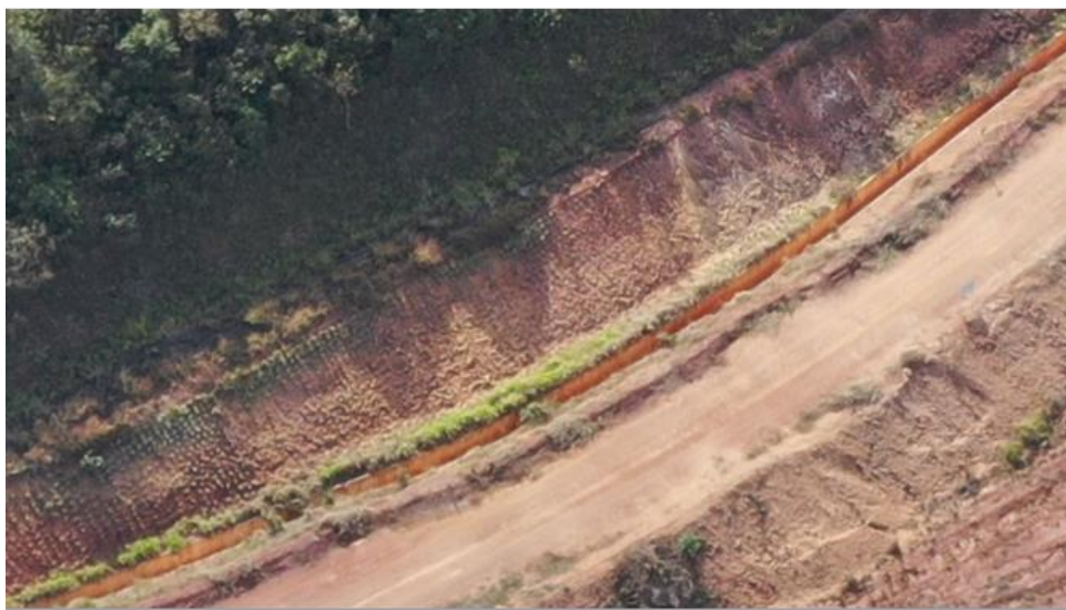
Figura 30: Canal de desvio.
