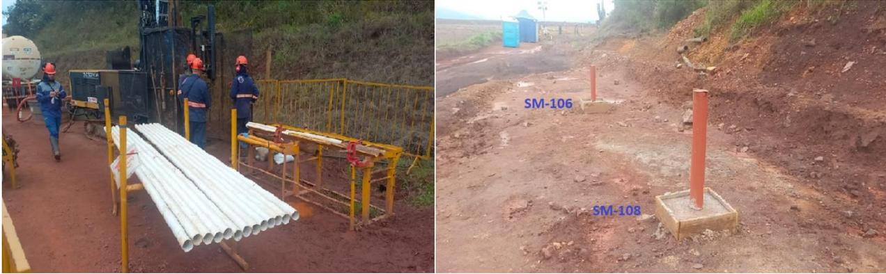
Figura 142: Sondagem o montante na Barragem.
