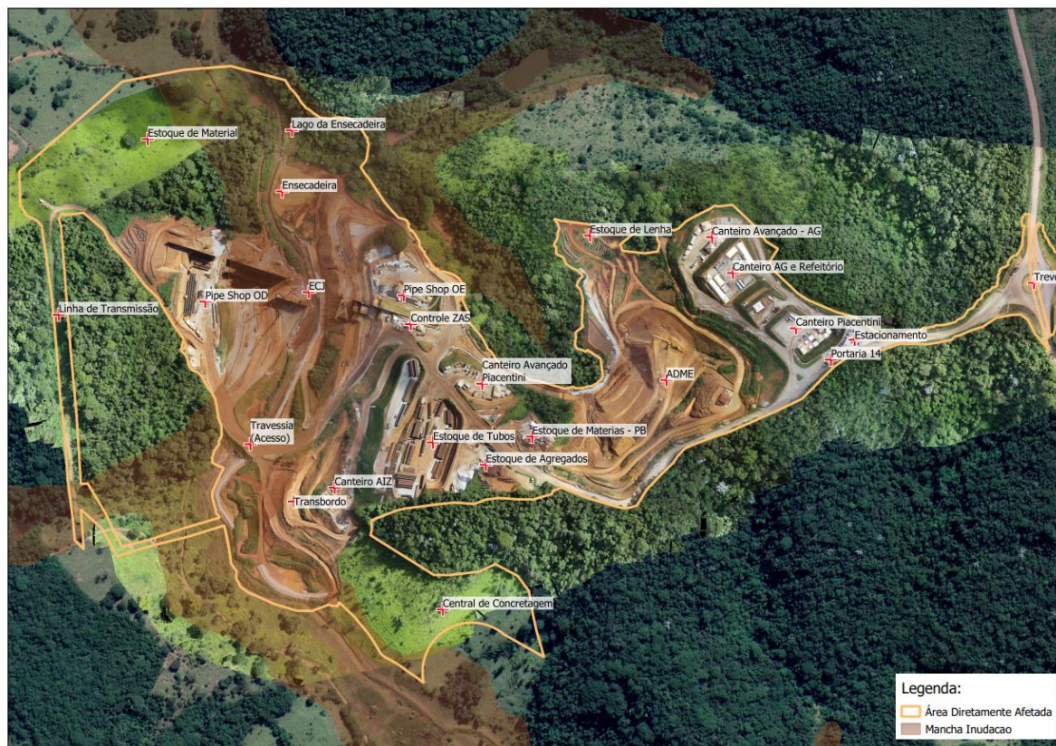
ECJ - Estrutura de Contenção a Jusante
