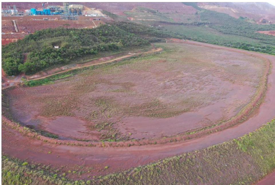
Figura 28: Ombreira Direita (Reservatório).
