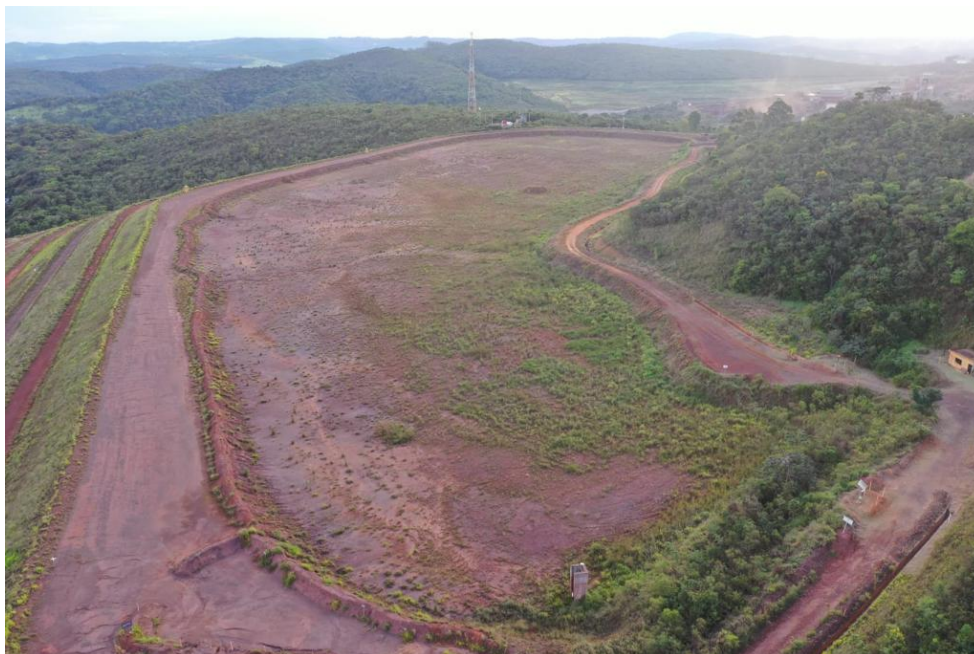
Figura 27: Ombreira Esquerda (Reservatório).
