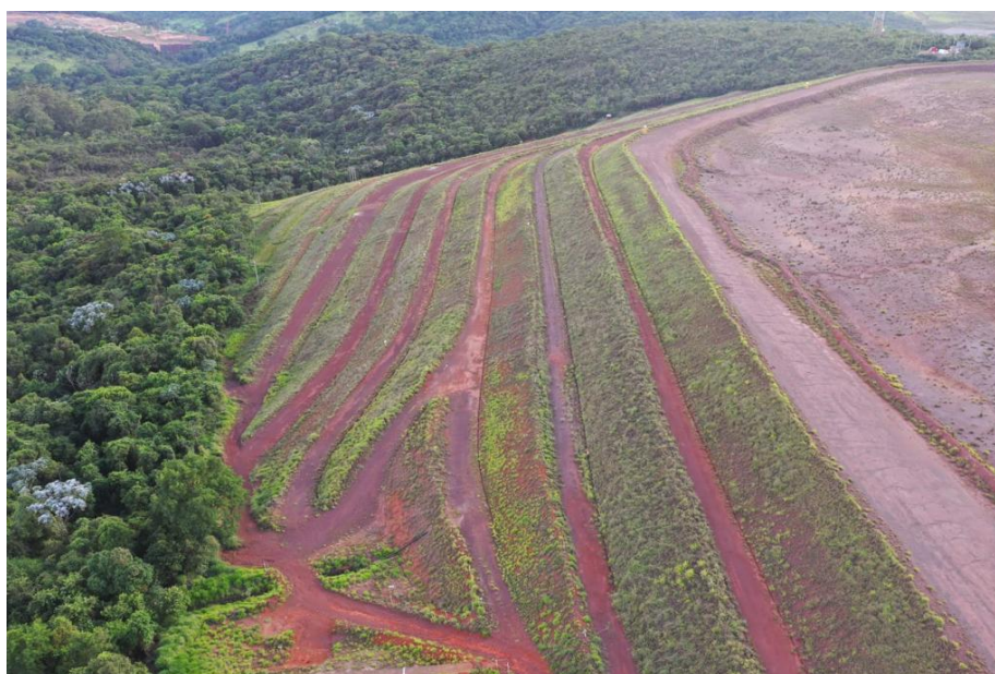
Figura 29: Taludes a jusante (Ombreira Esquerda).
