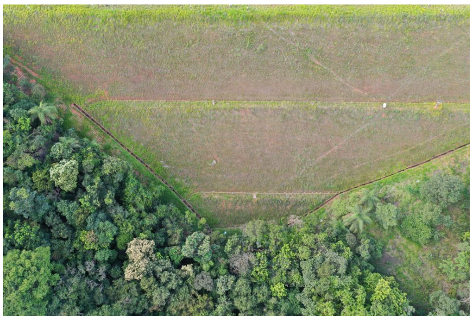
Figura 31: Taludes a jusante (Dique da Barragem).
