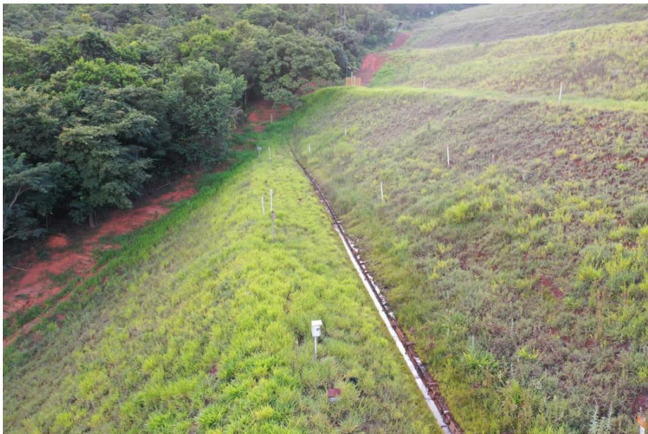
Figura 23: Cota 952 (saída da drenagem)
