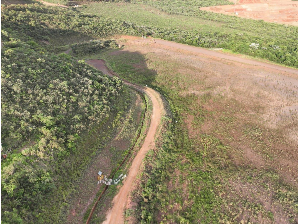
Figura 32: Montante a Barragem (canal de drenagem).
