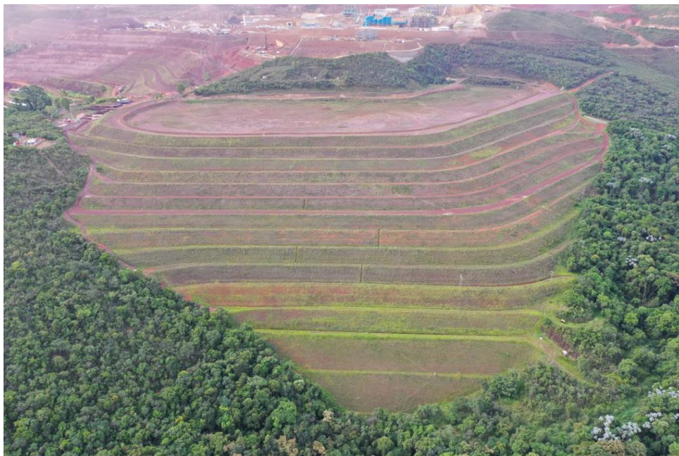
Figura 33: Barragem de rejeitos (Serra Azul).
