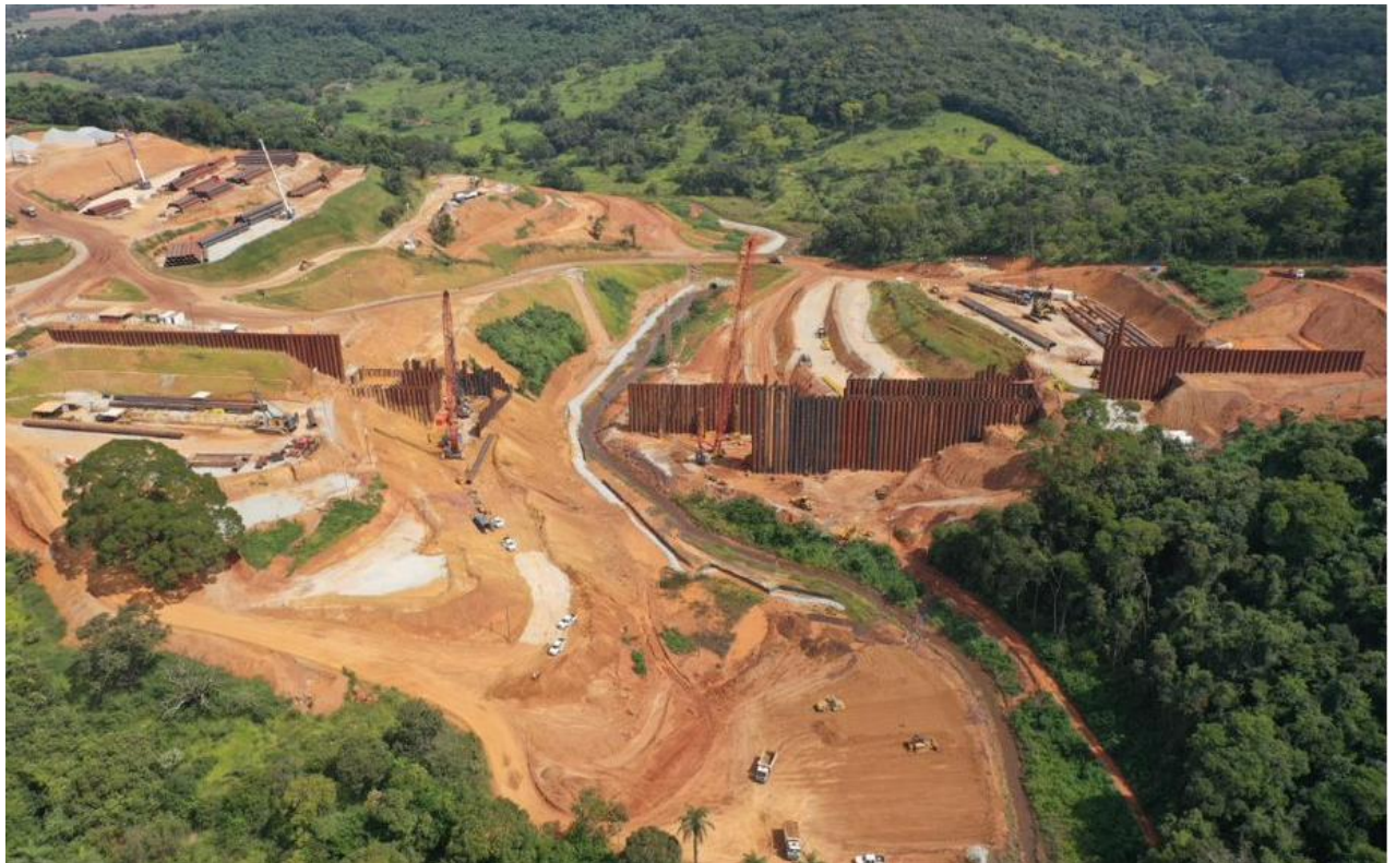
Vista Obra – Estrutura Operacional da ECJ – Abril/2023 (Aço e Gnaisse – Mista).
