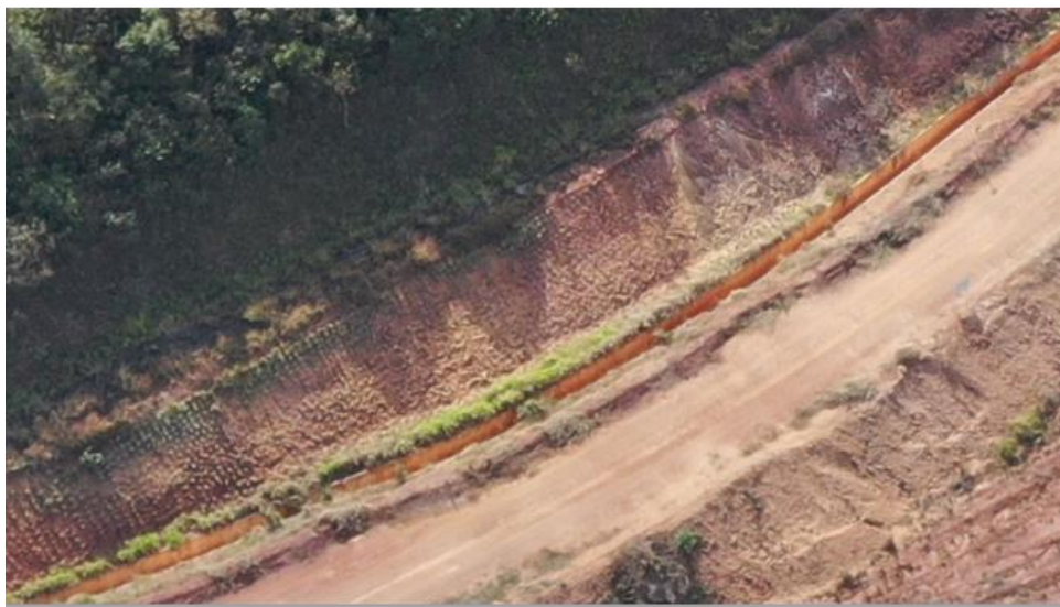
Imagem 4: Canal de desvio.
