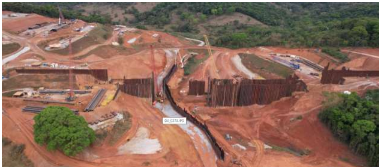
Vista Obra – Estrutura Operacional da ECJ – outubro/2023 (Aço e Gnaisse – Mista).
