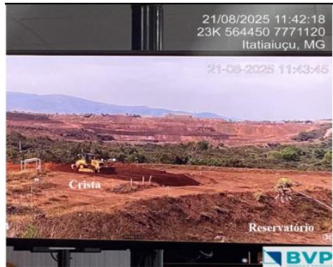
Figura 30: Detalhe do trator realizando o encaixe do acesso a barragem. Fonte da Imagem: BVP
