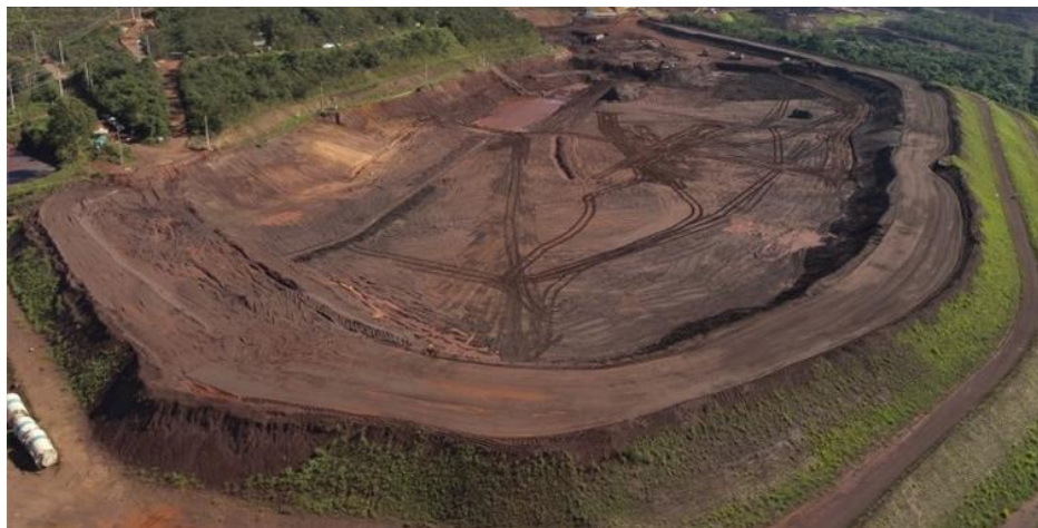
Figura 35: Escavação de rejeito.
