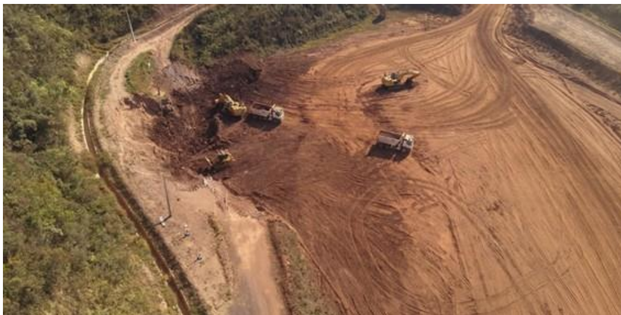
Figura 32: Detalhe da escavação de um dos dois sump's na área da barragem
