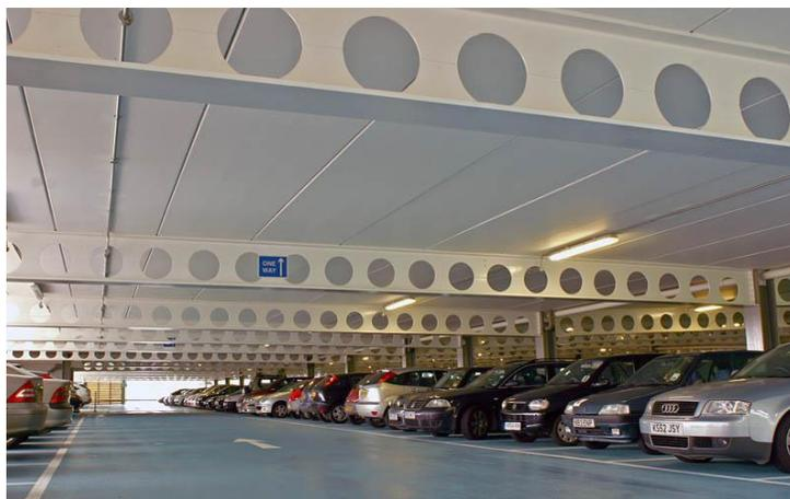
Figura 13 – Sistema de piso de um estacionamento com vigas celulares.
