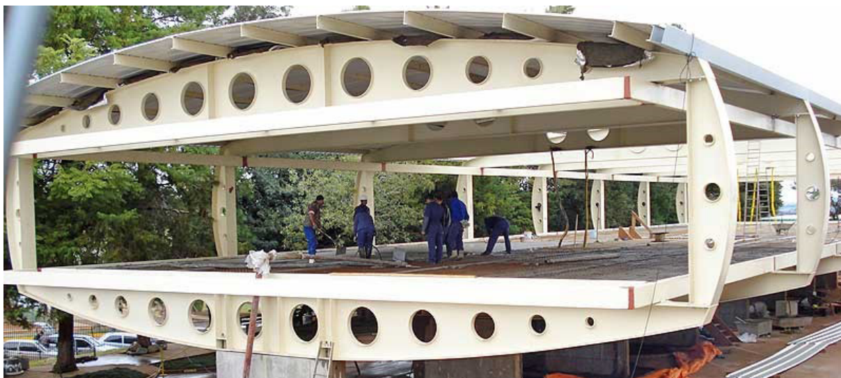
Figura 8 – Vigas celulares soldadas com geometria especial
