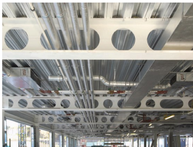
Figura 40 – Alongamento da abertura para passagem de tubulação. (fonte: www.westok.co.uk – acessado em 11/05/2011)
