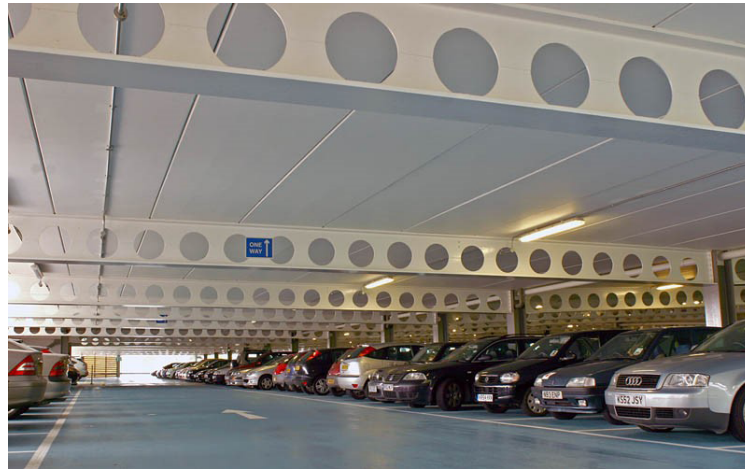
Figura 18 – Sistema de piso de um estacionamento com vigas celulares. (Milton Keynes Car Park, Inglaterra – foto: Westok)
