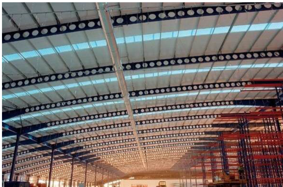
Figura 41 – Viga celular rigidamente ligada a perfis de alma cheia nas extremidades (fonte: www.westok.co.uk – acessado em 11/05/2011).
