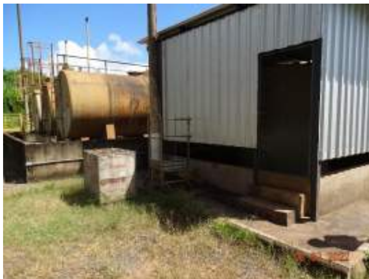
Figura 66 - Área de armazenamento de Arla
