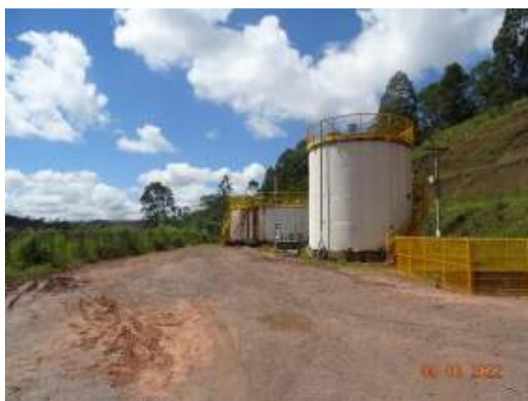
Figura 89 - Estação de Tratamento de Água - ETA
