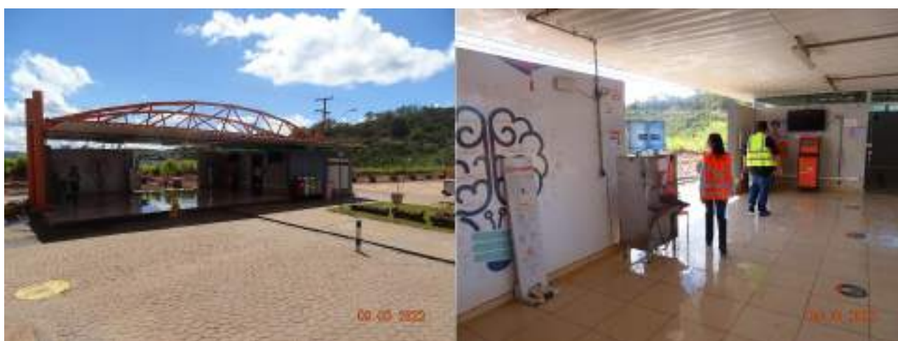
Figura 48 - Vista para Área de Convivencia
