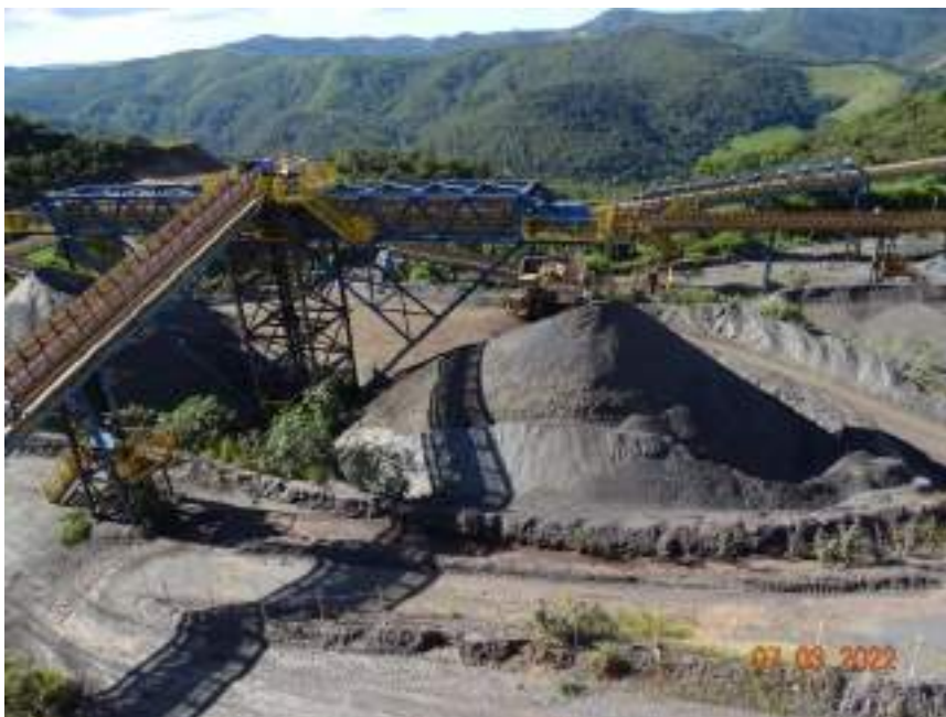
Figura 20 - Vista geral para o transporte e peneiramento.
