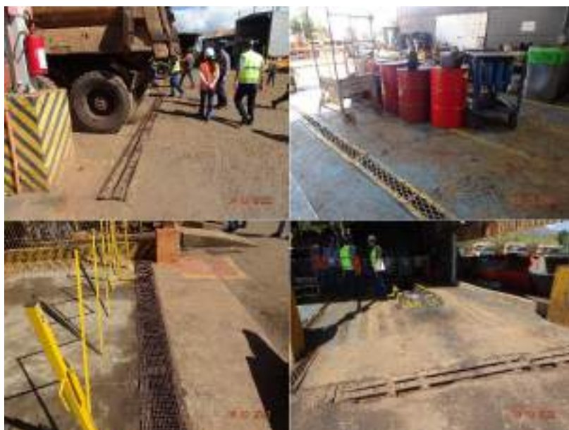
Figura 52 - Vista para rede de canaletas
