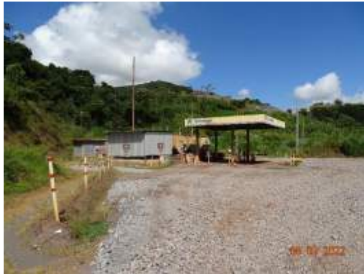
Figura 64 - Vista para área do posto de combustível
