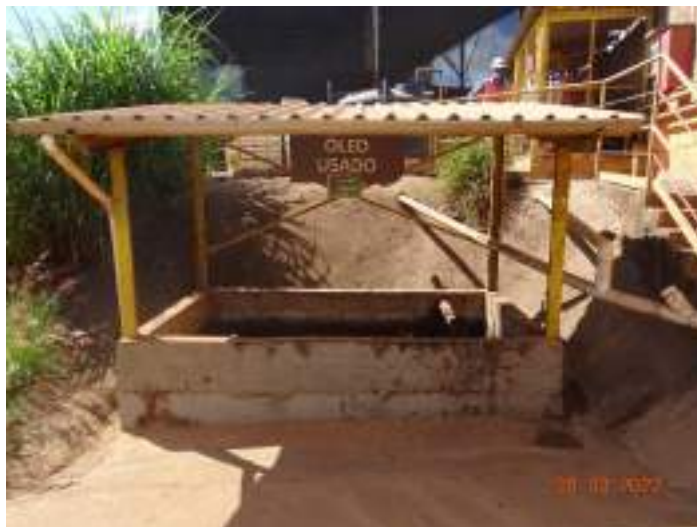
Figura 61 - Tanque de armazenamento de óleo usado
