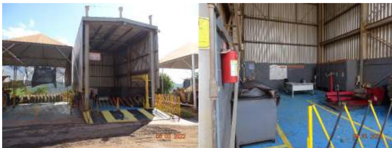
Figura 53 - Vista para área de borracharia
