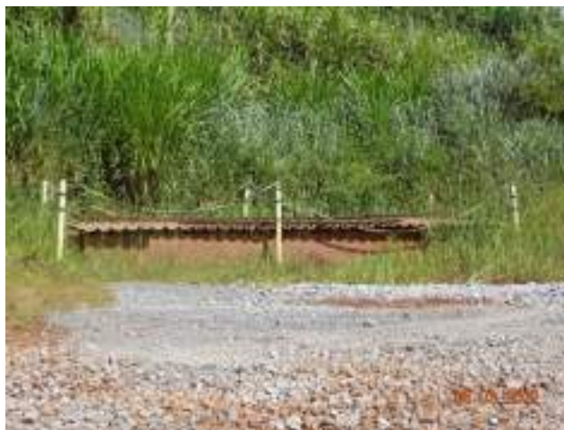
Figura 84 - Caixa SAO posto de combustível
