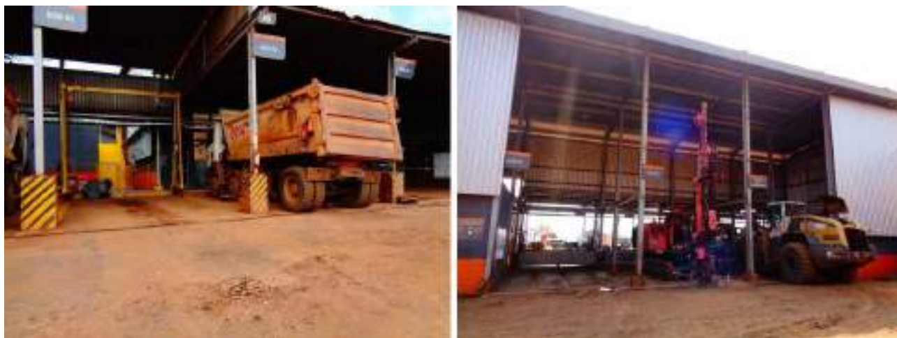
Figura 51 - Vista para boxes de manutenção veicular
