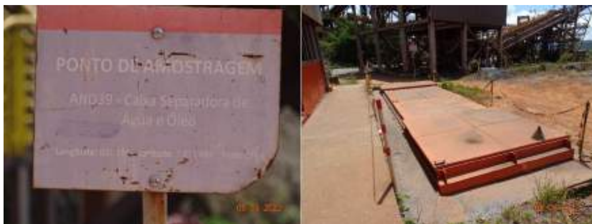
Figura 83 - Caixa separadora água e óleo oficina da mineração
