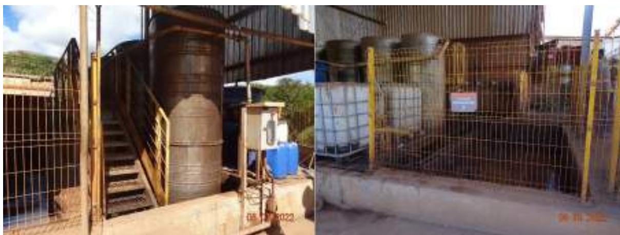
Figura 85 – Sistema de recirculação e tratamento de efluentes oleosos.
