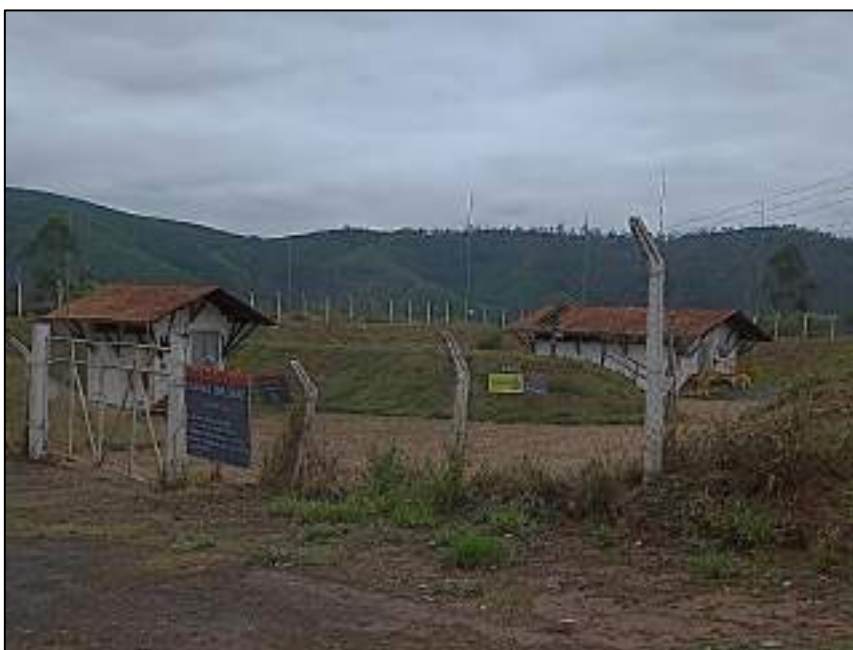
Foto 6.3 – Paiol de explosivos da mina
