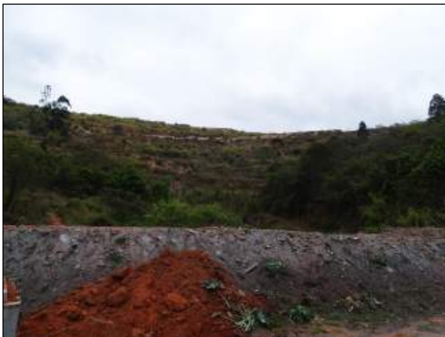
Figura 7.10 – Vista da área revegetada no pé da PDE 06
