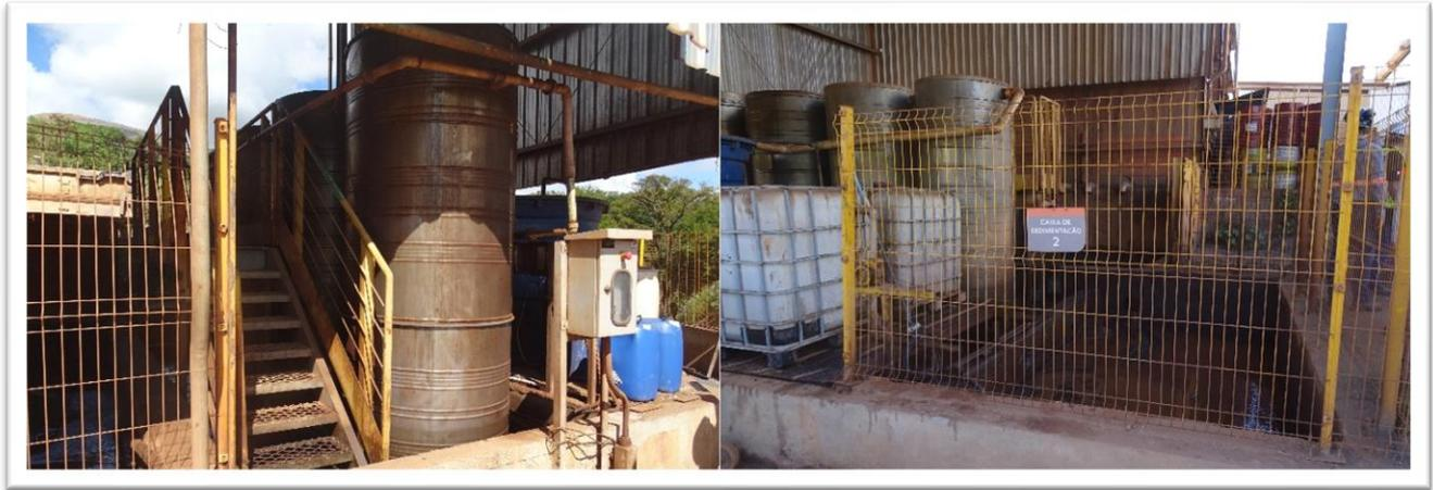
Figura 31 - Caixa SAO com recirculação e tratamento de efluentes oleosos.
