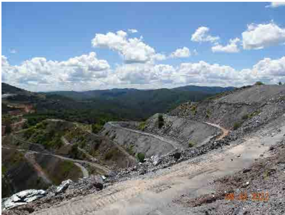
Figura 49 - Área de Mineração na Área Diretamente Afetada.
