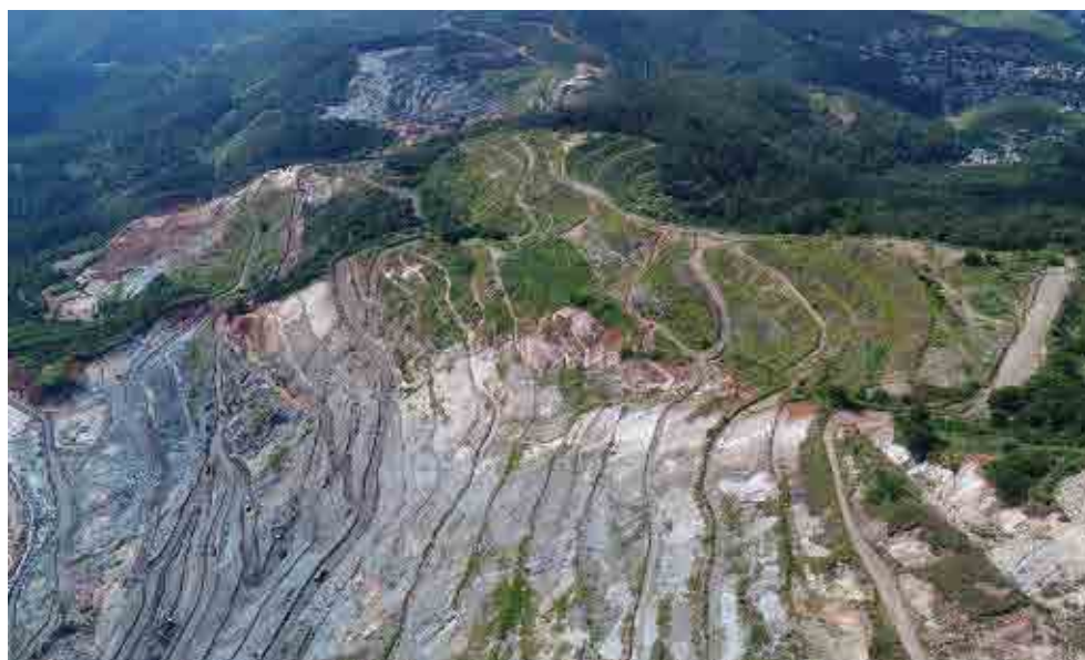
Figura 54 - Cava e PDE08, localizadas na ADA do projeto
